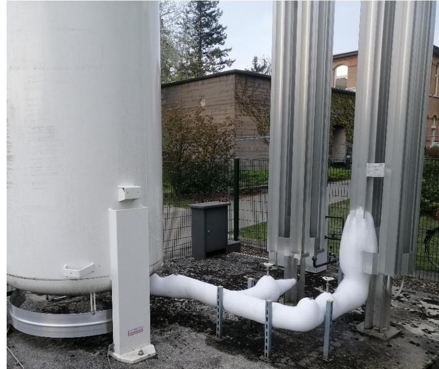
Abbildung 1: Eisbildung bei der Entnahme von flüssigem Sauerstoff ( T_{O_2} \approx -180^\circ\text{C} ) für ein Krankenhaus
