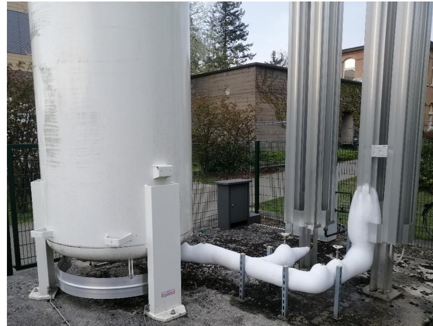
Abb. 1: Sauerstoffversorgung für ein Krankenhaus aus einem Flüssigsauerstoffspeicher ( T_{\text{O}_2} \approx -180^\circ\text{C} )
