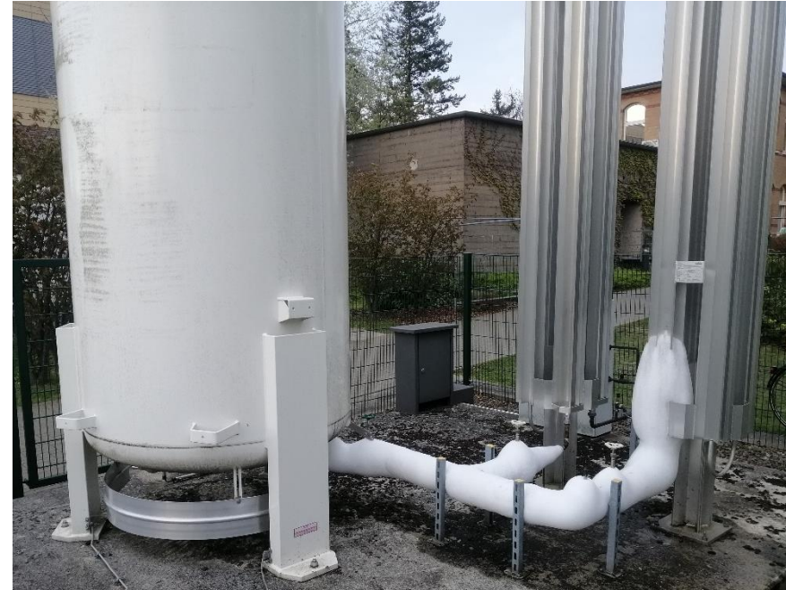
Abb. 1: Sauerstoffversorgung für ein Krankenhaus aus einem Flüssigsauerstoffspeicher ( T_{O_2} \approx -180^\circ\text{C} )
