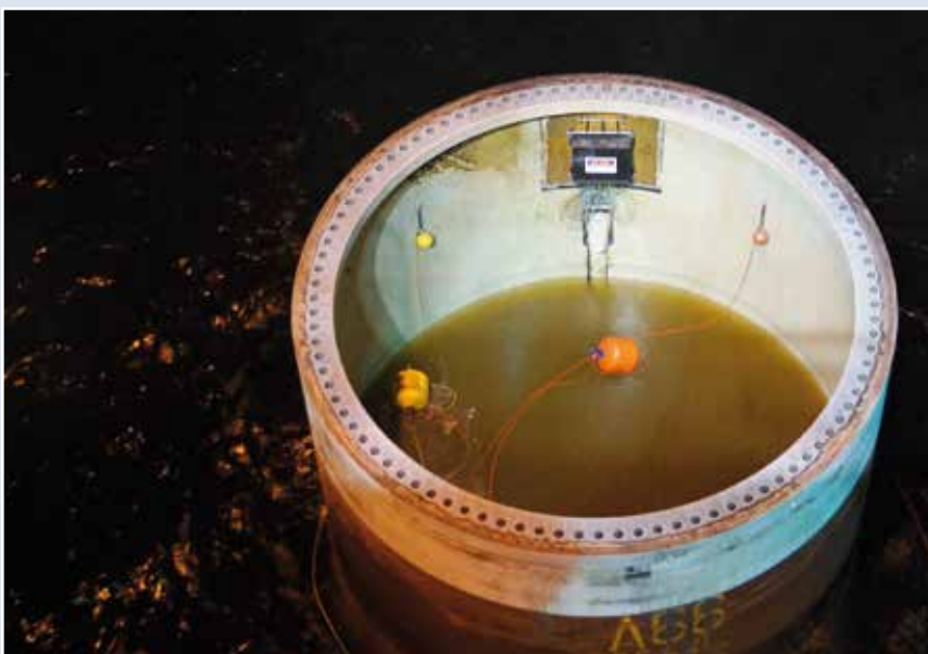
Bild 3: Unmittelbar nach dem Einrammen eines 60 m langen Monopahls wird nach Abheben des Hammers der Blick auf die angeklebte Lagerplatte mit elastisch aufgehängter Messbox frei
