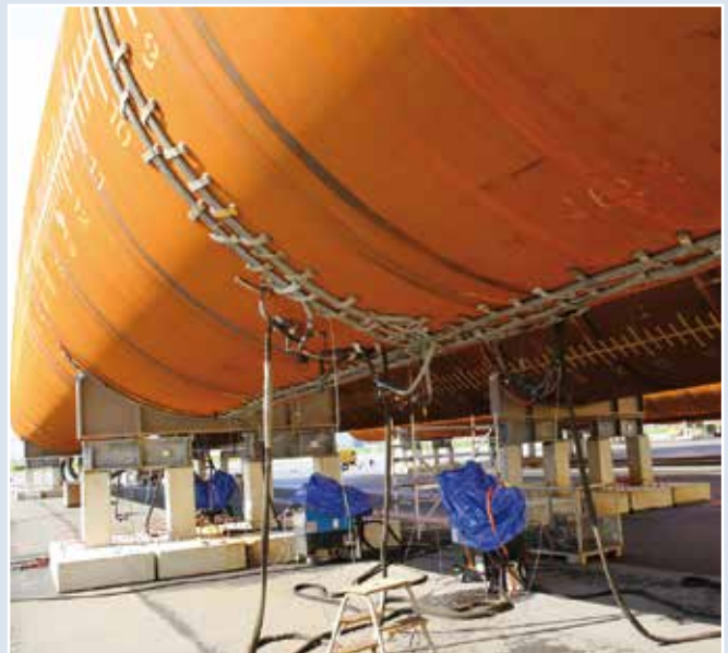
Bild 1: Umfangreiche Maßnahmen zur Schaffung kontrollierter Umweltbedingungen am Monopfahl; maßgeschneiderte Planen zum Verschluss der Pfahlenden und Warmluftheizung für innen (links), Induktionsheizung zur Temperierung der Pfahlwände im Klebbereich außen (rechts) | alle Bilder IGB-TUBS
