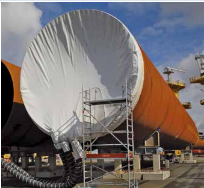
Bild 1: Umfangreiche Maßnahmen zur Schaffung kontrollierter Umweltbedingungen am Monopfahl; maßgeschneiderte Planen zum Verschluss der Pfahlenden und Warmluftheizung für innen (links), Induktionsheizung zur Temperierung der Pfahlwände im Klebbereich außen (rechts) | alle Bilder IGB-TUBS
