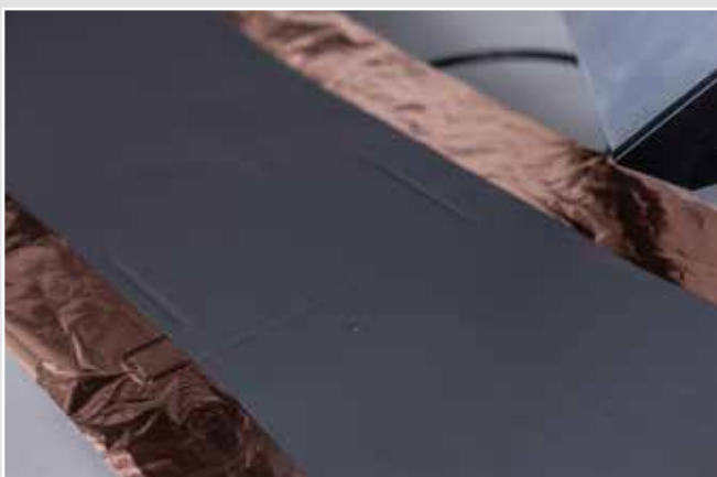
Bild 4: Positionierung der Anode mit Hilfe der Vakuumvorrichtung
