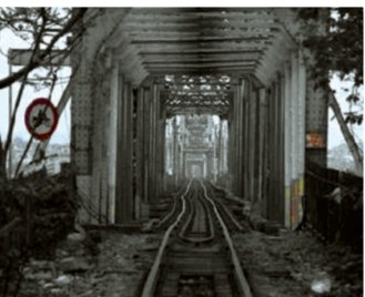
Abb. 1: Eisenbahnbrücke über den roten Fluss in Indien
