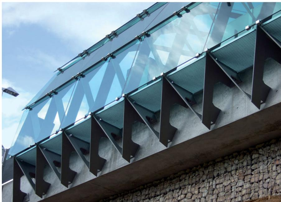
*Bild 6. Natürliche Entwässerung durch schindelförmig überlappende Glasscheiben (Foto: osd - Ingenieure)*
