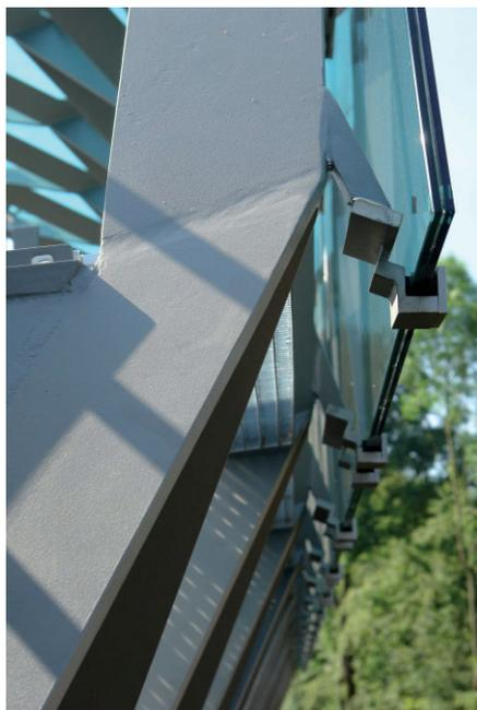
*Bild 5. In den polygonalen Knickpunkten der Stahllamellen angeschweißte Glashalter aus Edelstahl (Foto: osd-Ingenieure)*
