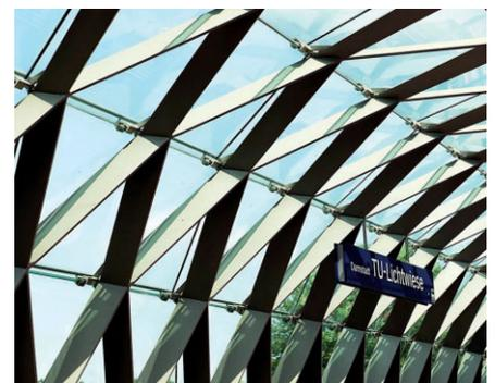
*Bild 4. Stahlgitterschale an den Momentenverlauf angepasst und mit biegesteifen Schweißknoten verbunden (Foto: Dieter Leistner)*
