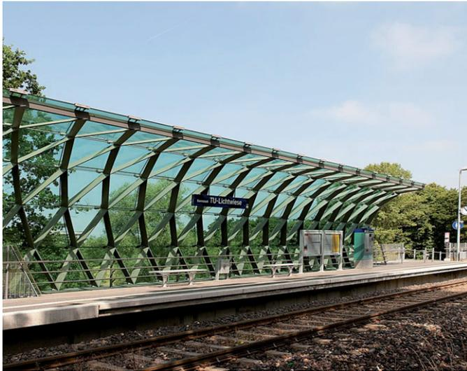
*Bild 2. Transparente Überdachung als Glas-/Stahlkonstruktion der Odenwaldbahn-Haltestelle in Darmstadt (Foto: Dieter Leistner)*
