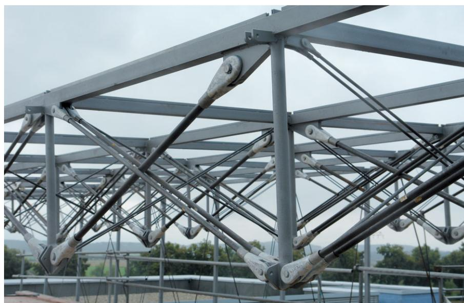
Bild 15. Zugstabsystem für die Unterspannung in der Montage (Foto: osd-Ingenieure)
