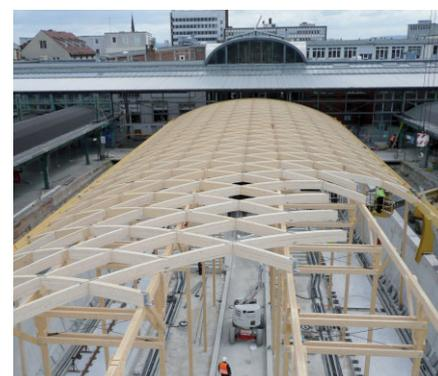
*Bild 1. Holzgitterschale am Kasseler Hauptbahnhof (Foto: osd – Ingenieure)
