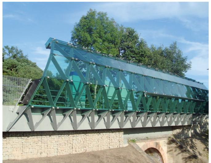
*Bild 3. Fließender Übergang von der Horizontalen in die Vertikale durch die Wahl eines Zylinderausschnittes für die auskragende Dachkonstruktion der Odenwaldbahn-Haltestelle (Foto: osd – Ingenieure)*
