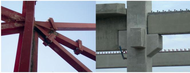
**Bild 2** Standard im Stahlbau und Stahlbetonfertigteilbau: Fügen von Halbzeugen (Profilen) aus industrieller Produktion [Foto KLOFT]
