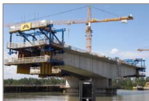
Baustelle Donaubrücke Traismauer
