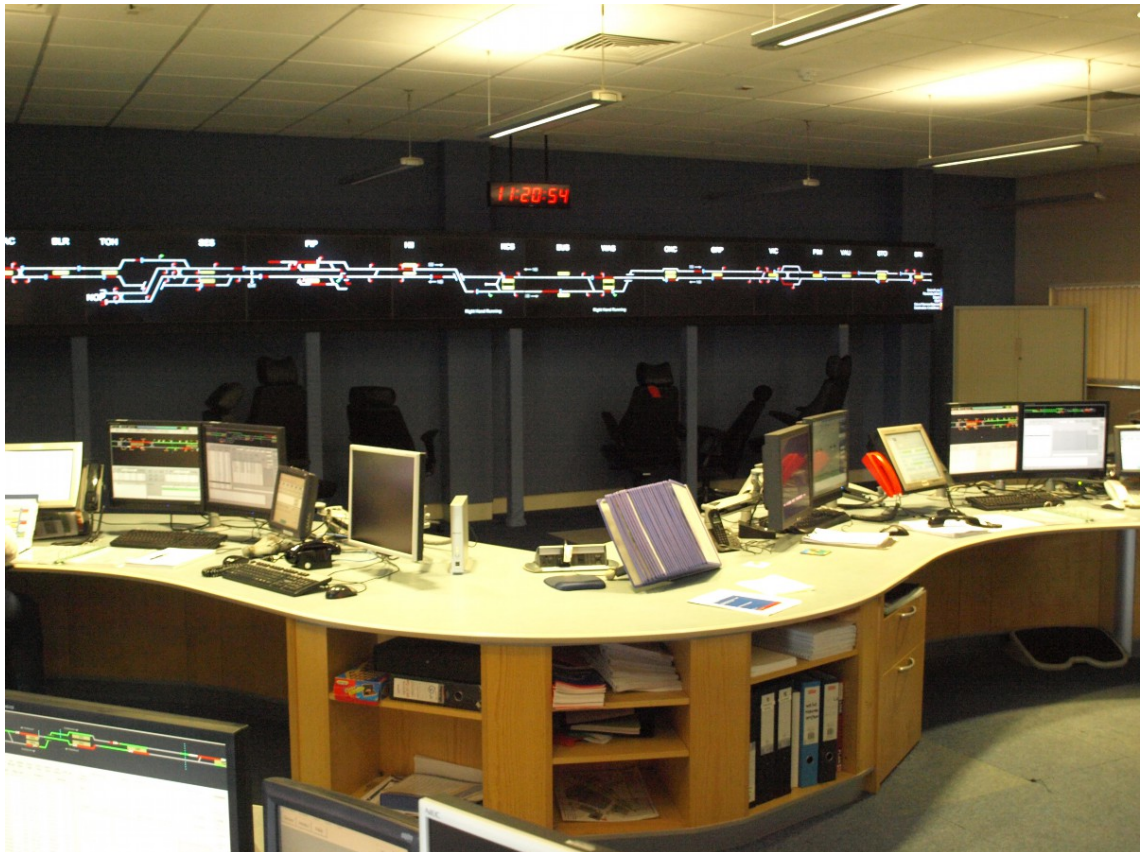
Abb. 10 Im Vordergrund zwei Arbeitsplätze; im Hintergrund das Streckenband mit dem Betrieb auf der Victoria Line
