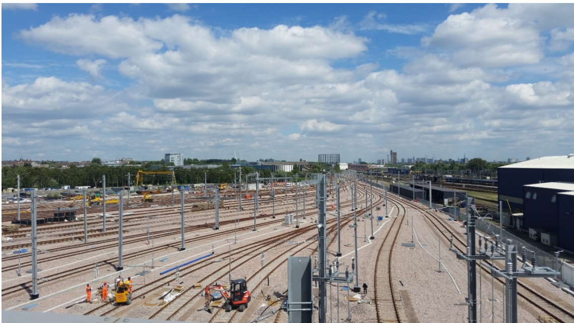
Abb. 22 Gleisvorfeld der Halle
