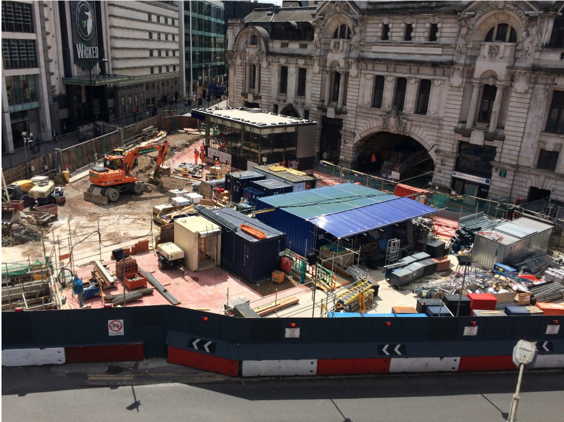
Abb. 19 Die aktive Baustelle direkt vor dem Theater (Hintergrund).
