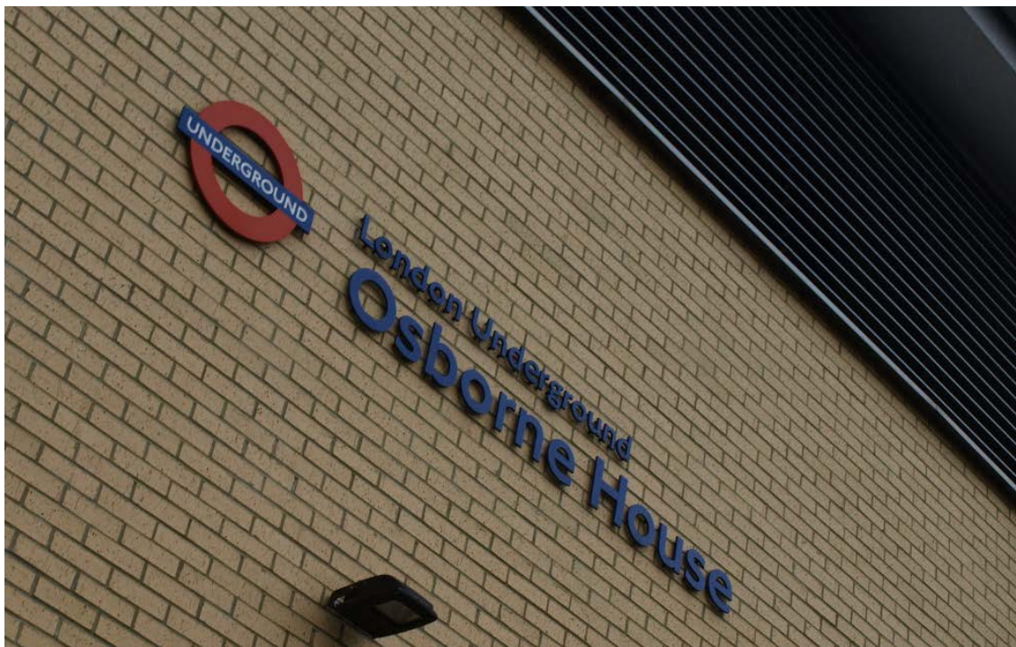
Abb. 7 Osborne House, Zentrale der Victoria Line
