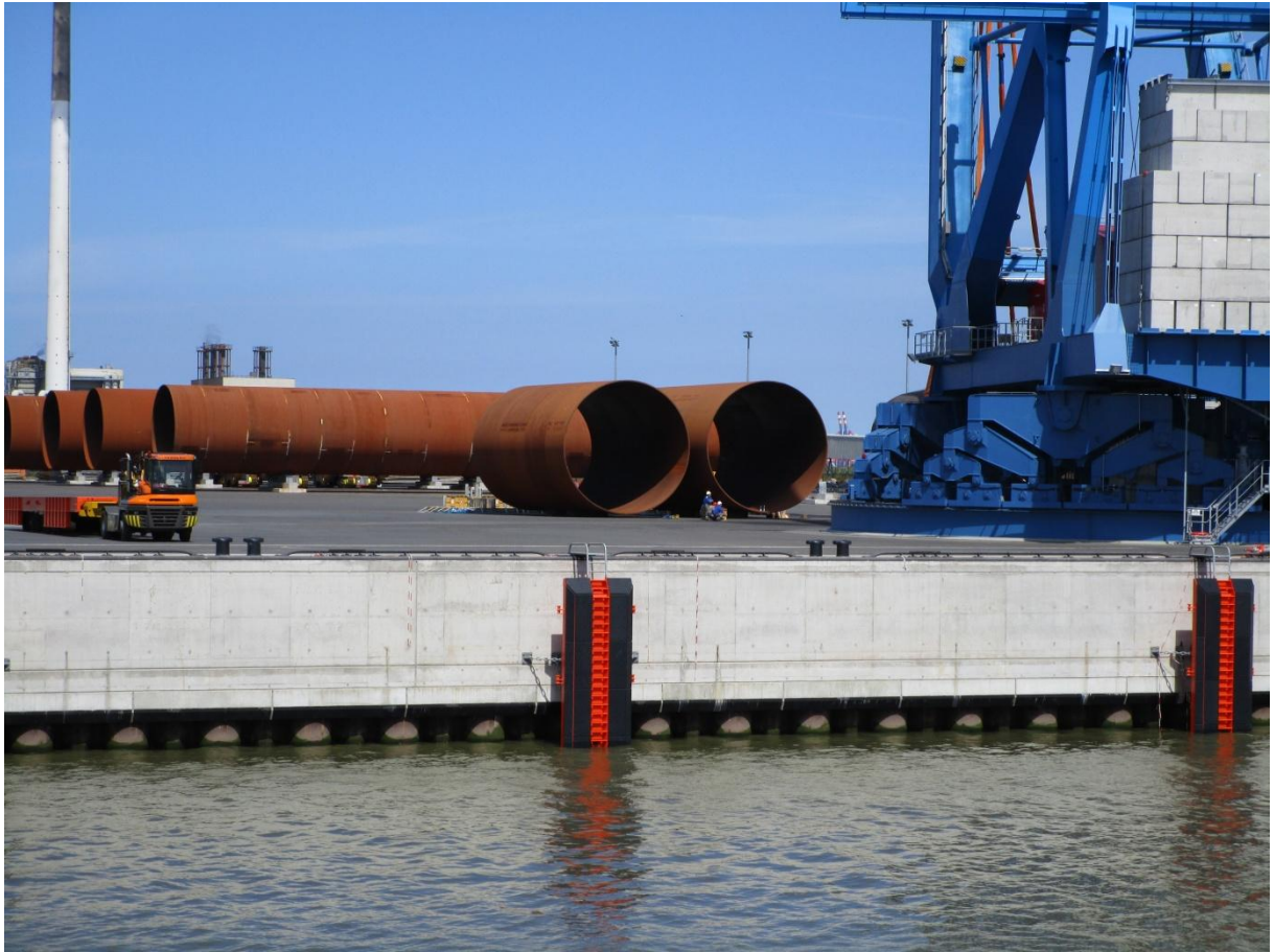
Abbildung 11. Von der Fähre ein Blick zur Schwerlastkaje mit den Monopiles.
