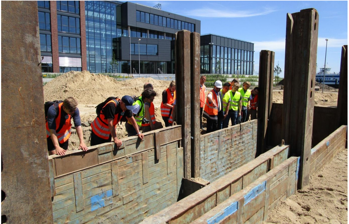
Abbildung 6. Blick in einen neuen Entwässerungskanal und den anstehenden Klei-Boden.
