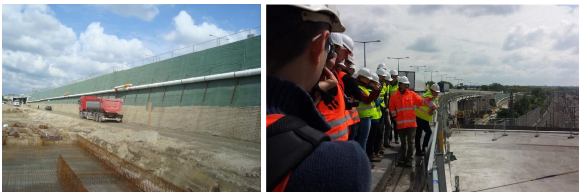
Abbildung 17. Dammschüttung (li.), Abrissstelle des alten Tragwerks (re.).
