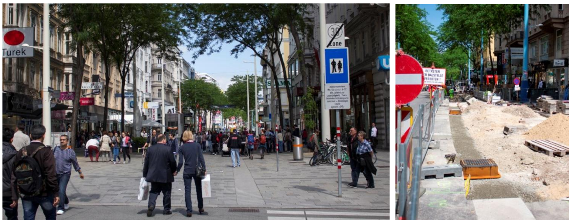
Abbildung 24. Blick in die fertige Mariahilfer Straße (li.), Baustellenblick (re.).
