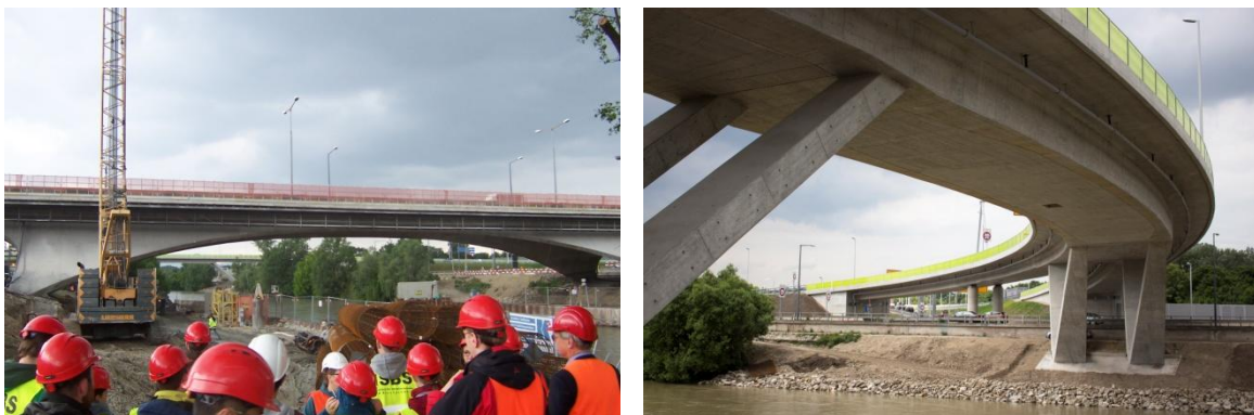
Abbildung 19. Das alte vorgespannte Schalentragwerk muss weg (li.), Entlastungsbrücke als Hohlkastenbrücke mit V-Stützen (re.)
