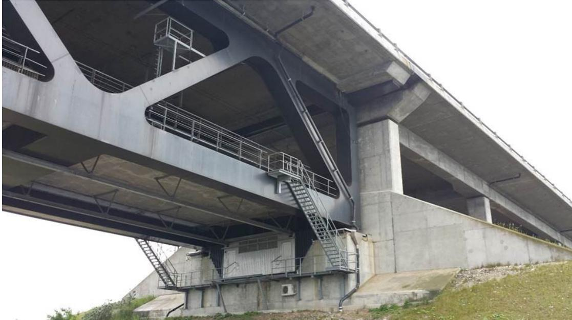
*Abbildung 18: Die Zugtrasse unterhalb der Öresundbrücke*
