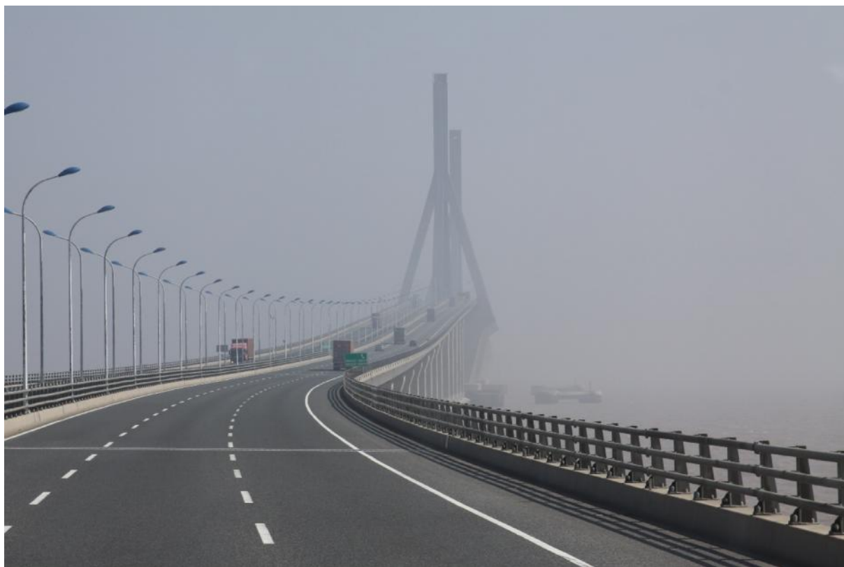
Bild 64: Fahrt über die Donghai Bridge, Foto: J. Flemming
