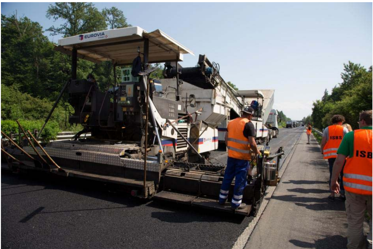
Abbildung 10. Einbau der Asphaltdeckschichte.
