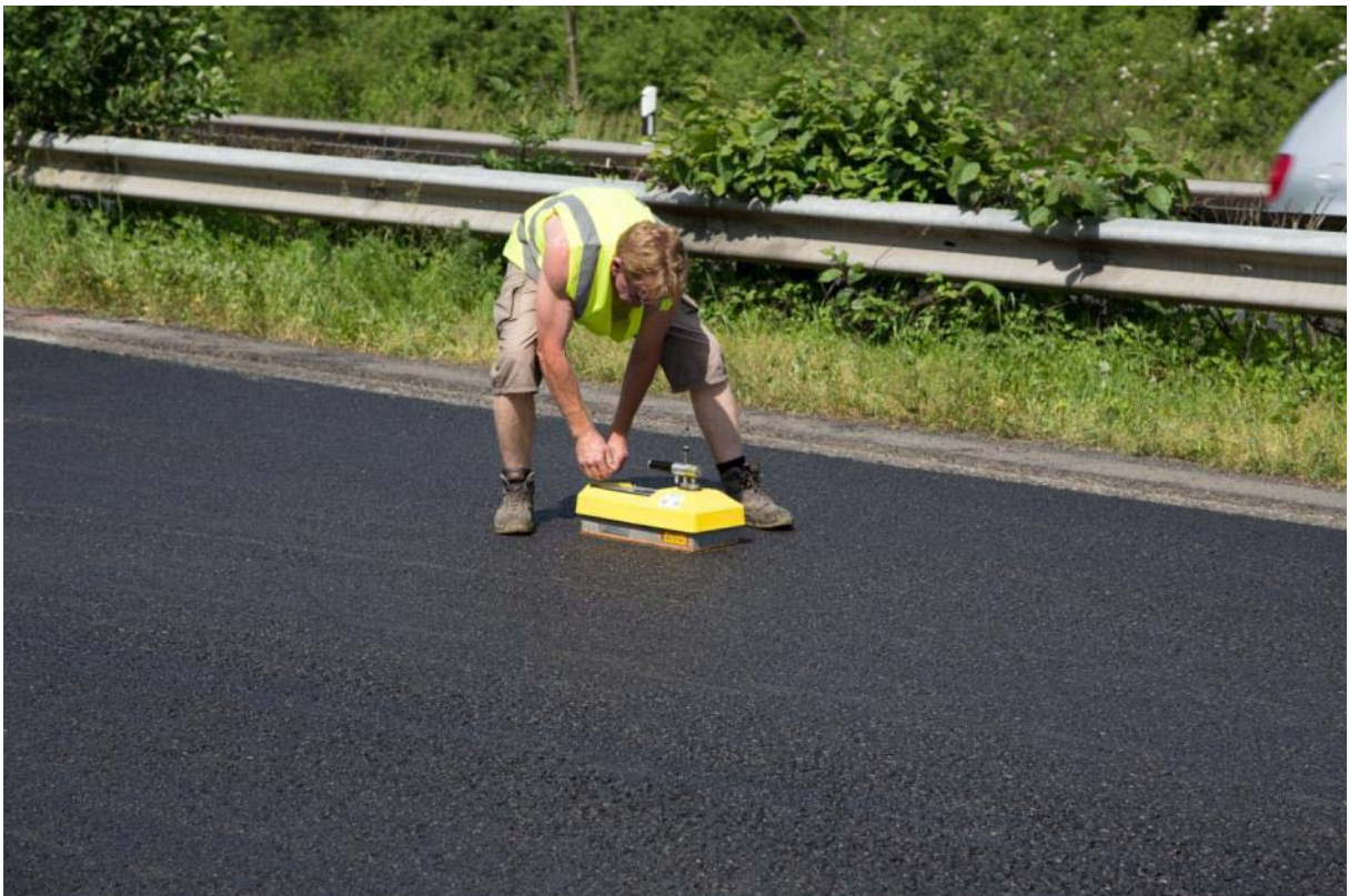
Abbildung 12. Dichtemessung mittels Troxlersonde.
