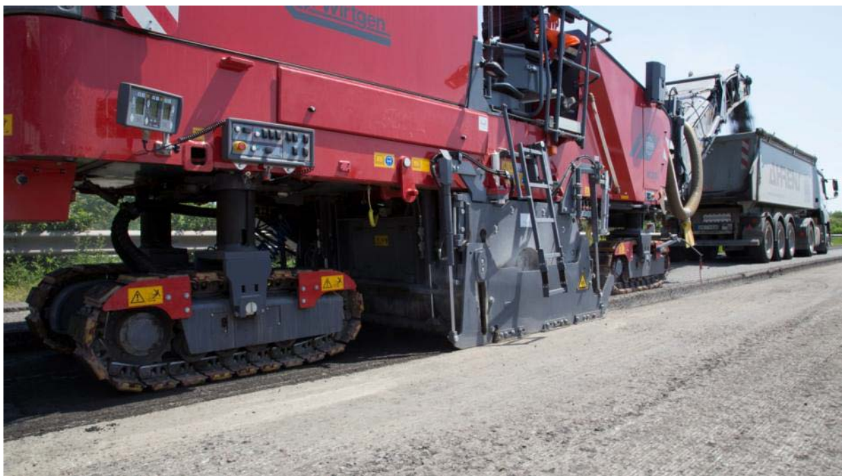
Abbildung 8. Fräsen in einer Arbeitsbreite von 2,10 m.
