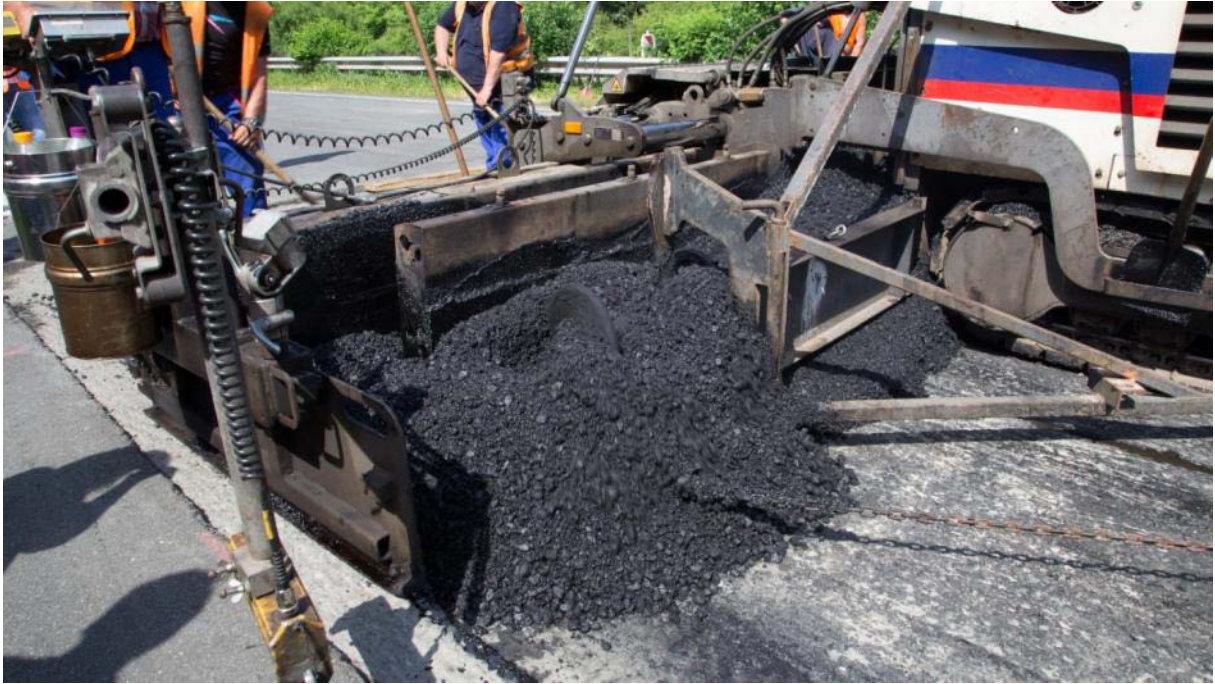
Abbildung 9. Mischgutquerverteilung mittels Verteilerschnecke.
