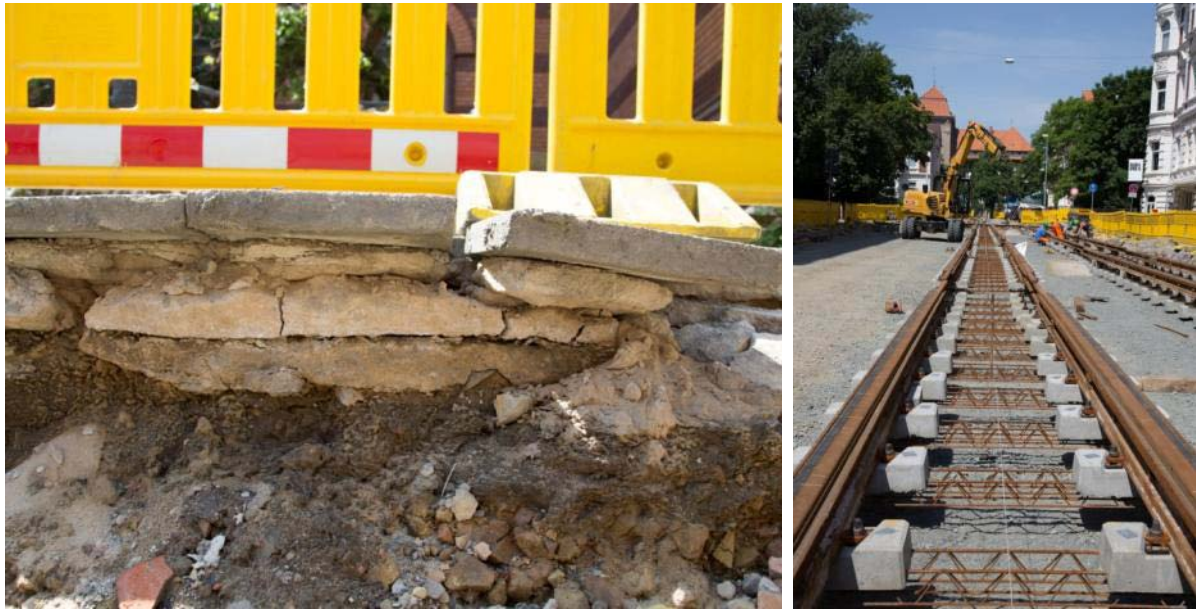
Abbildung 5a/5b. Sanierung Leonhardstraße West, Braunschweig.
