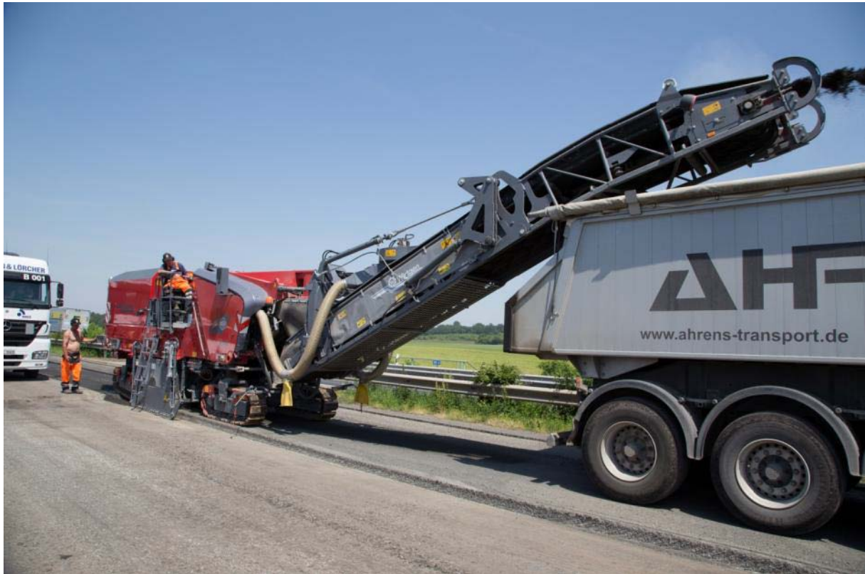
Abbildung 7. Fräsarbeiten auf der A 395.
