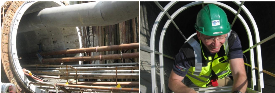
Abbildung 7. Besichtigung der Metrobaustelle II.
