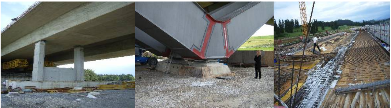
Abb.3 Provisorische Stützen
