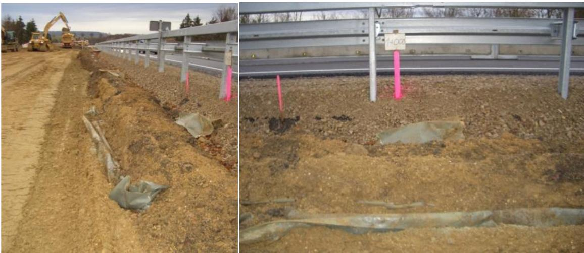
**Abbildung 9. Folie zum Schutz vor aufsteigendem Grundwasser unter dem Unterbau.**
