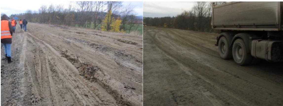
Abbildung 6. Unterbau vor Bodenverbesserung (li.), Unterbau nach Bodenverbesserung (re.).
