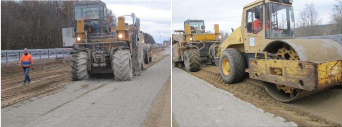
Abbildung 7. Baumischverfahren zur Bodenverbesserung von vorne (li.) und von hinten (re.).
