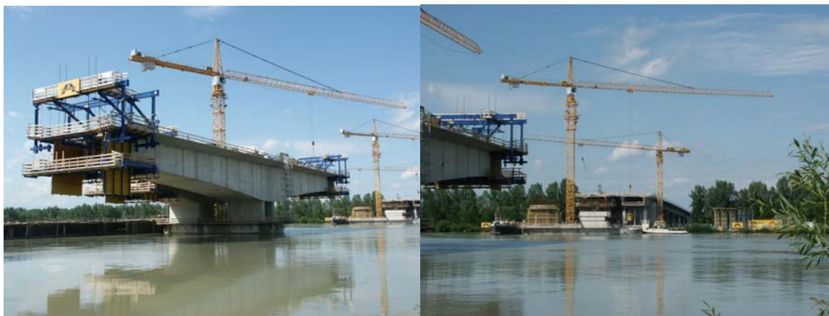
Abbildung 11. Tragwerk im Vorbau.
