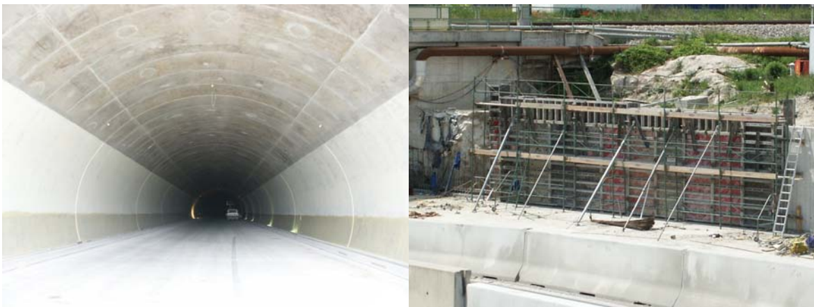
Abbildung 18. Impressionen von der Baustelle.
