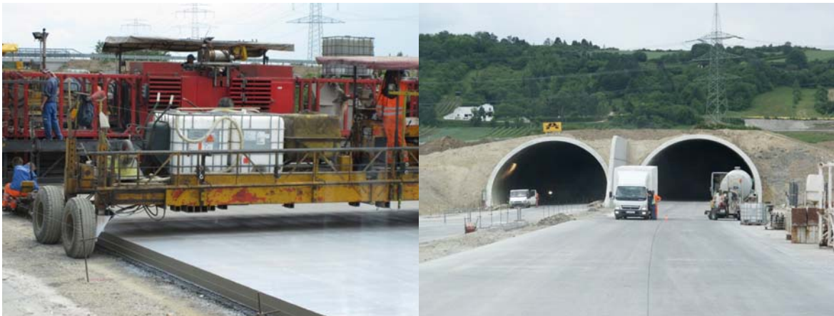
Abbildung 17. Betoneinbau (li.), Tunnelportal (re.).
