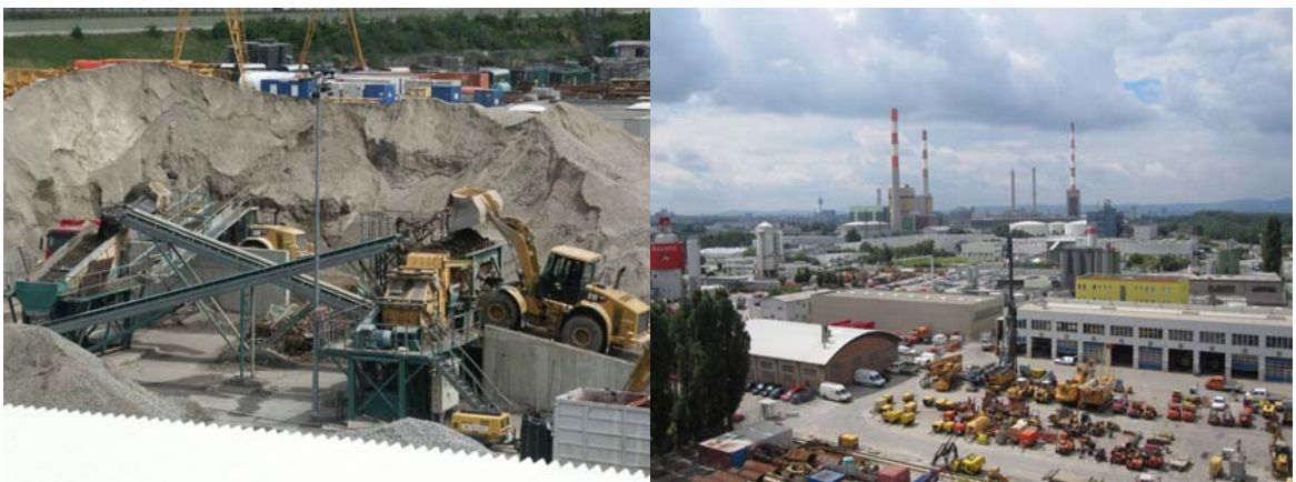
Abbildung 7. Gesteinsaufbereitung (li.), Areal des Asphaltmischwerks (re.).
