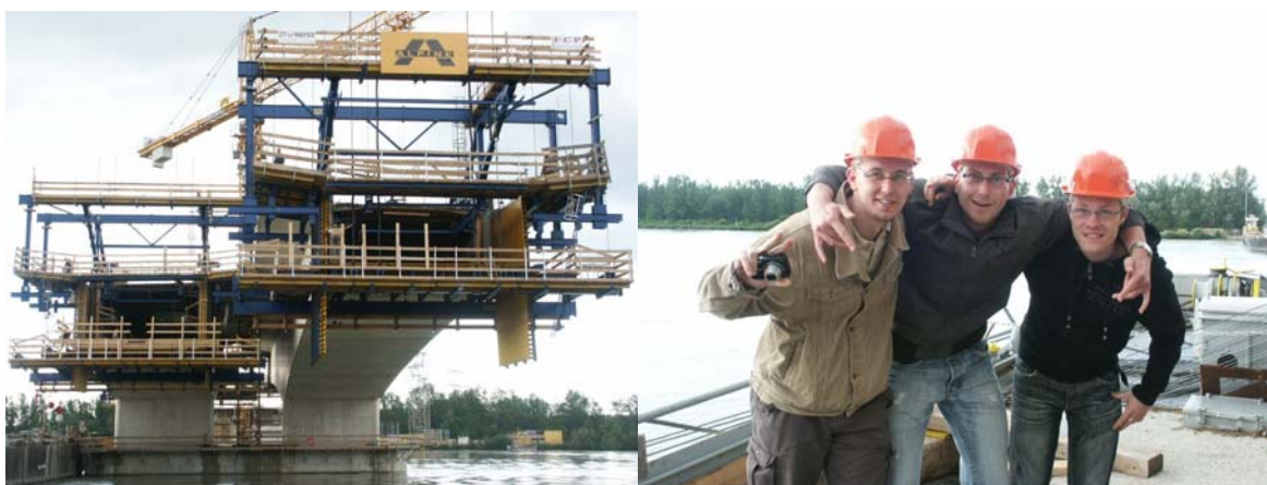
Abbildung 12. Impressionen von der Baustelle „Donaubrücke Traismauer“.
