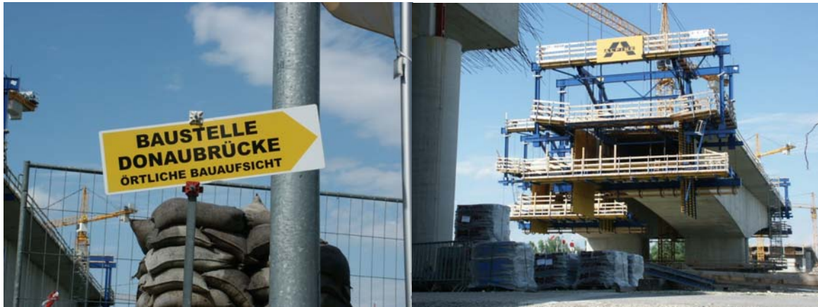
Abbildung 10. Impressionen von der Baustelle „Donaubrücke Traismauer“.
