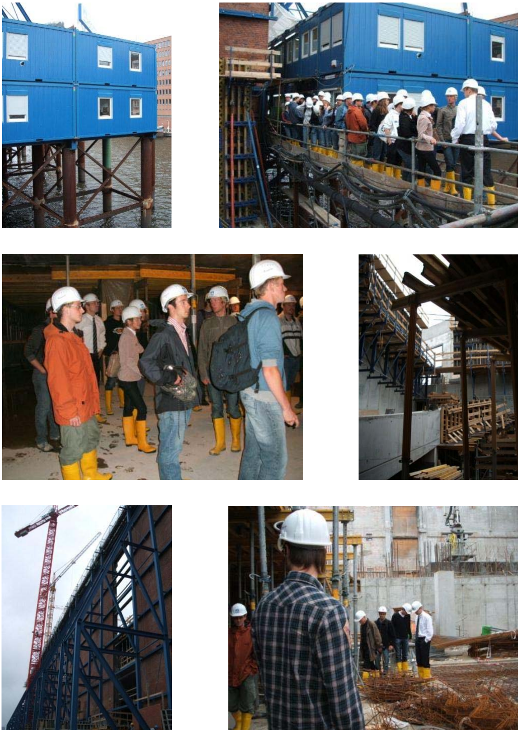
Abbildung 1. Impressionen von der Baustelle der Elbphilharmonie.
