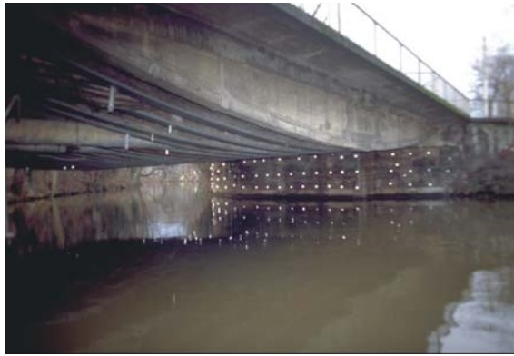
Abb. 1: Blick auf die Okerbrücke aus nord-östlicher Richtung. Deutlich erkennbar sind die Reflexfolien am westlichen Widerlager (Foto: B. Riedel).
