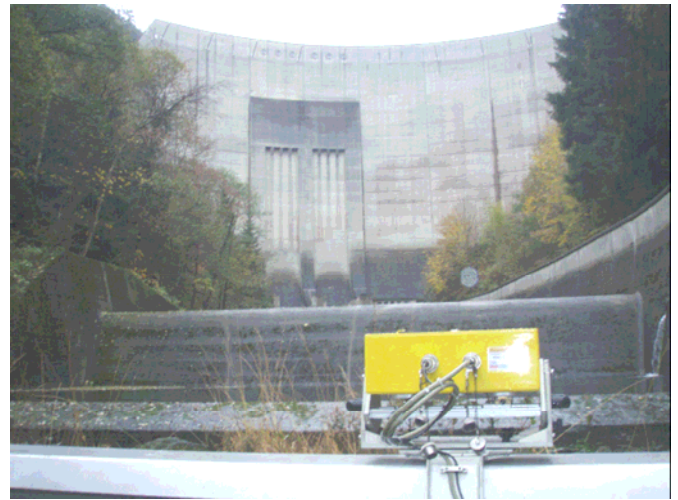
Abb. 1: IBIS-L System zur Erfassung der Deformationen der Okertalsperre / Harz
