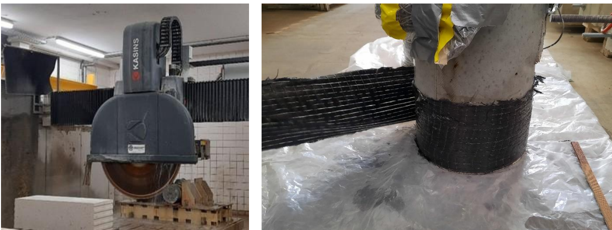
Bild D-4: Sägen einer runden Stahlbetonstütze (links) und Kleben der CFK-Gelege (rechts)
