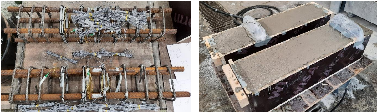
Bild D-3: Bewehrungskörbe (links) und frisch betonierte Stützen (rechts)
