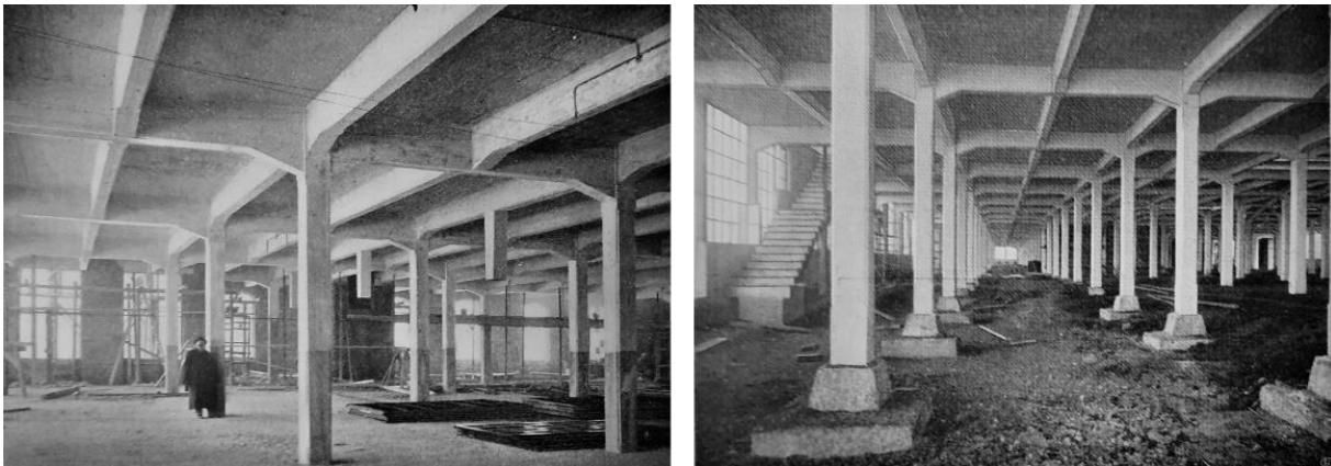
Bild 4-3: 1904: Eisenbetonstützen in der Baumwollspinnerei in Speyer (links) und in der Daimler-Motorenfabrik bei Stuttgart (rechts) [Mör-06]
