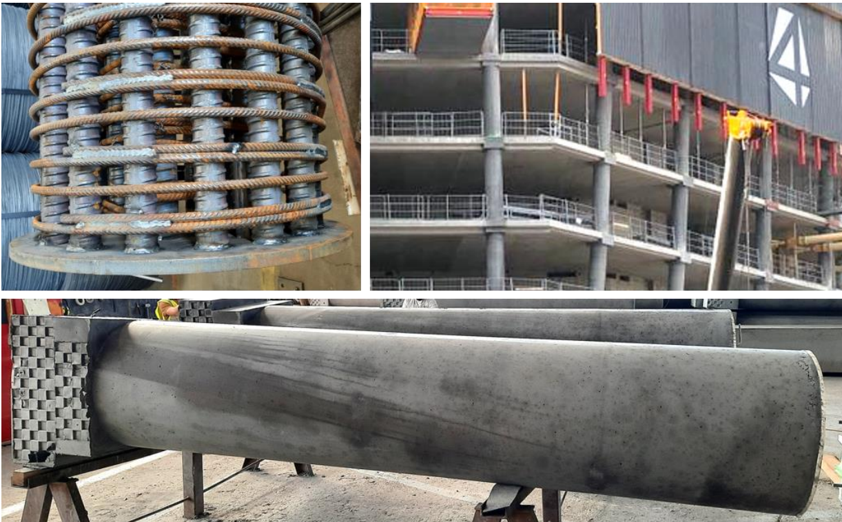
Bild 3-13: Hochhausprojekt Four: Bewehrungsdetail am Stützenfuß (oben links), Foto der gestoßenen Stützen (oben rechts) und Fertigteilstütze im Werk der SACAC AG in Lenzburg (unten) [Fotos: H. Matz]
