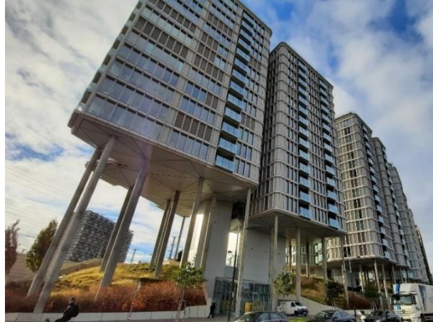
Bild 4-8: Parkapartments am Belvedere in Wien mit hochfesten Schleuderbetonstützen
