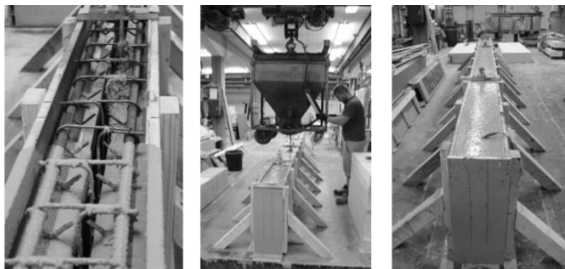
Bild 5-3: Betonage der Versuchskörper
