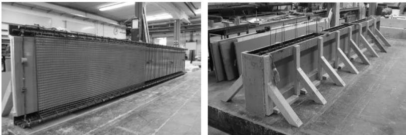
Bild 5-2: Bewehrungskorb und Schalung der Versuchskörper
