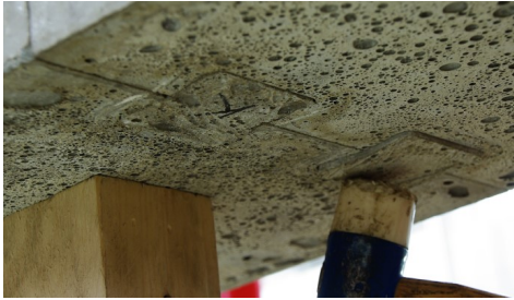
Bild 4.20 Fügung der UHPFRC-Passstücke mithilfe eines Kunststoffhammers [Leh16]
