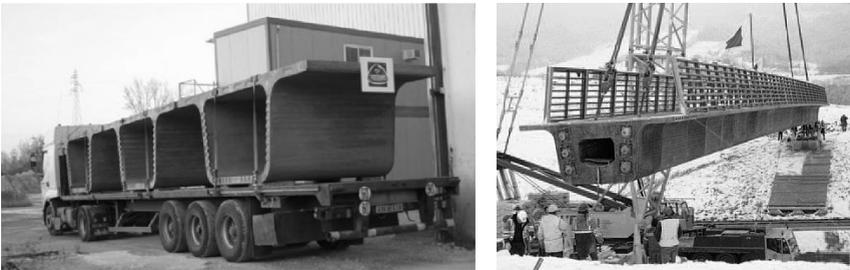
**Bild 5-1: Vorgefertigte UHPFRC-Segmente (links) [Del-2011] und Montage des vor Ort zusammengespannten Überbaus der PS34-Brücke (rechts) [Vav-2005]**
