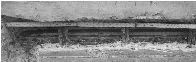
Abb. 5-27 typische Spannstahlentnahme an einem bestehenden Bauwerk zur Beurteilung der Gefährdung gegenüber Spannungsrisskorrosion
