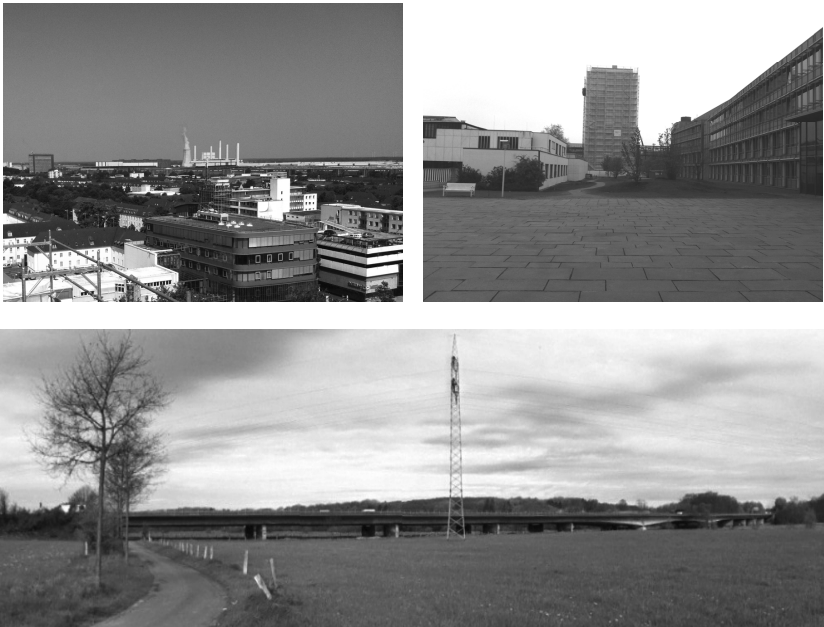
Abb. 1-1 Typische Massivbauwerke: Industriegebäude (oben links), Verwaltungsgebäude (oben rechts) und Brücken (unten)
