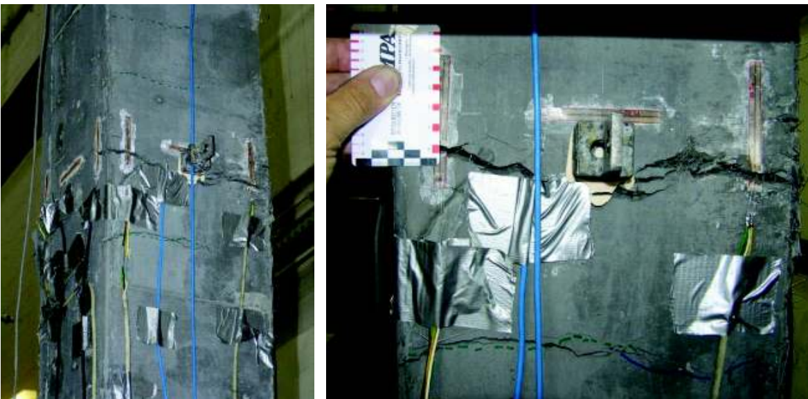
Bild H-10: C1 in Stützenmitte kurz vor Abbruch des Versuches (Nordseite)
