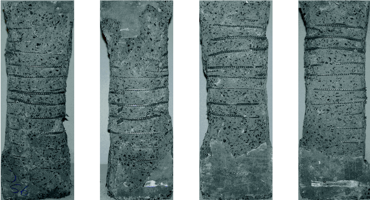
Bild E-15: UHPC-Stütze S6 nach dem Versuch
