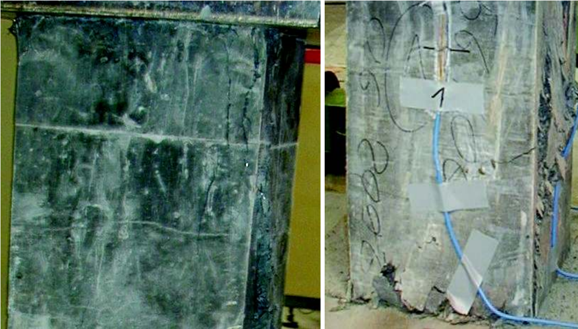
Bild E-5: UHPFRC-Stütze S2: Kurz vor dem Erreichen der Höchstlast beginnende senkrechte Rissbildung (links) und rechts Abplatzungen am Stützenfuß (Fotos wurden im Nachbruchbereich aufgenommen)
