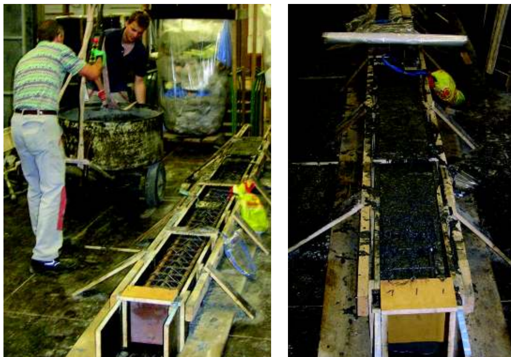
Bild H-4: Betonage der UHPFRC-Stütze C1
