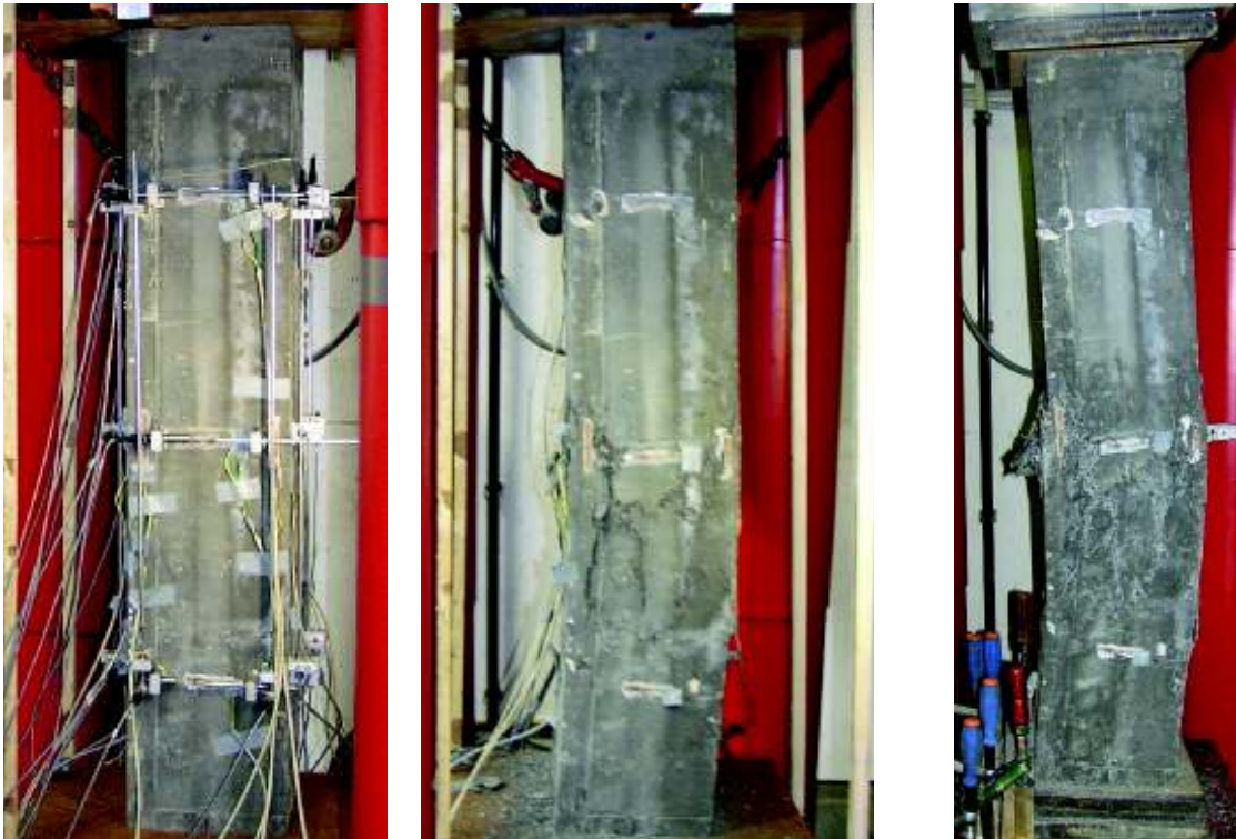
Bild G-9: UHPFRC-Stütze SE1 im Versuch (Ostansicht)
