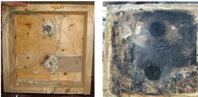
Bild 3.41 Untersuchung Konstruktionsdetails: Elektrodosen; Aufnahmen des Probekörpers nach dem Brandversuch [INO09]
