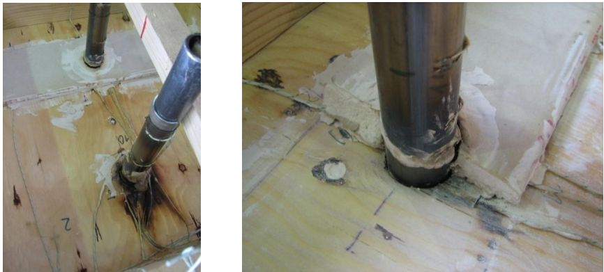
Bild 3.49 Untersuchung Konstruktionsdetails: Probekörper mit Rohrdurchführung; Innenseite nach dem Brandversuch [INO09]
