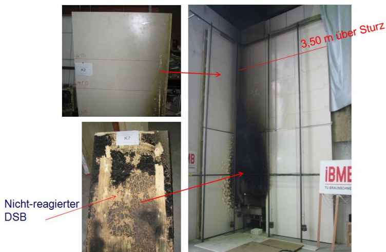
Bild 4.3 Beschädigung des Probekörpers beim Fassaden-Großbrandversuch [INO09]
