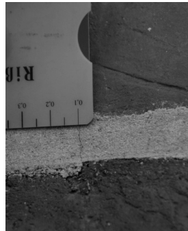
Abb. 4.5: Mörtelquerriss
