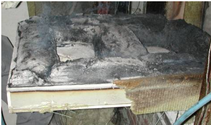
Bild 80: Fachwerkrahmen nach 30-minütiger Beflammung
