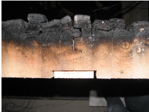
Bild 37: Abbrandtiefe in der Fuge Wand-Decke von BSH (am Elementstoß der Wand)
