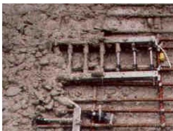
(b) Einbetonierte Anodenleiter
