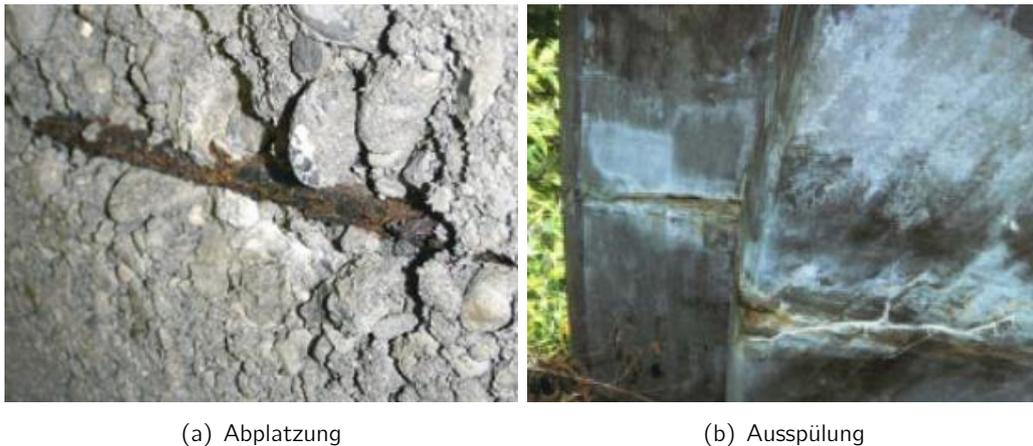
Abbildung 2.1: Bauschäden nach physikalischen Angriffen auf Beton [Thi06]
