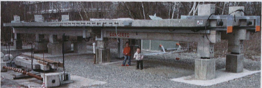
Abb. 8.1: SFB 477-Ersatzbauwerk „Concerto“ auf dem iBMB-Gelände zur Erprobung neuartiger Sensorik und Messverfahren 63 : Längsschnitt und Ansicht der 18 m langen, zweistegigen Plattenbalkenbrücke mit 2 fünflichtigen Längsspanngliedern je Steg (30 x 80 cm 2 ) sowie 12 Querspanngliedern in der Platte (400 x 25 cm 2 ); die Belastung erfolgt vertikal durch 2 Erdanker sowie über konsolengeführte externe Spannglieder, zudem ist eine Änderung des statischen Systems durch Auflagerverschiebung möglich; die Spannstahlkorrosion wird durch NaCl- und NH 4 SCN-Lösungen sowie durch Fremdstrom erzeugt
