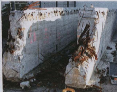
Längsträger der Hohen-zollerndammbrücke Berlin
