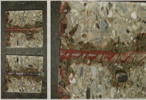
Abb. 3-12: Wassereindringfront/Farbverteilung in einem Versuchskörper mit Bewehrungsstahl nach dreitägiger Wasserbeaufschlagung mit 0,5 MPa.
