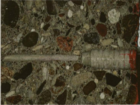
Abb. 3-8: Wassereindringprofil und Farbverteilung im Bereich der MRE nach druckfreier Wasserbeaufschlagung.
