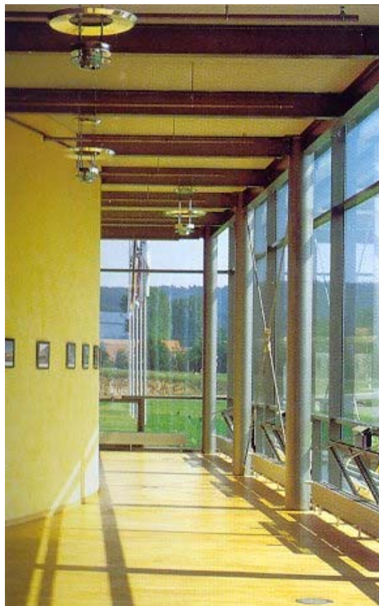
Bild 3 Ausführung ungeschützter Stahlbauteile in einem Bürogebäude (aus [GOB02])
