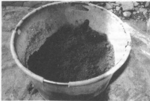
Bild 3.18: Erdfeuchter Mörtel M I der Innenschale
