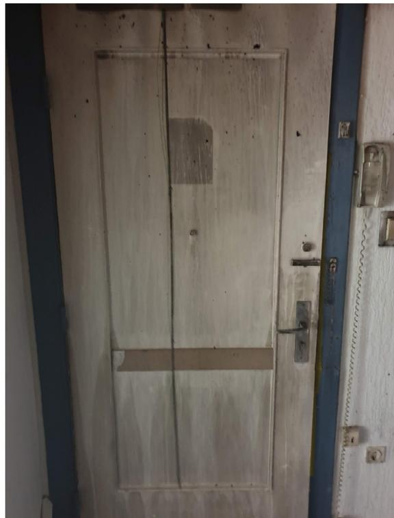
*Abbildung 3-2: Zustand der Wohnungseingangstüre nach dem Brandversuch 1, Außenseite (links) und Innenseite (rechts)*
