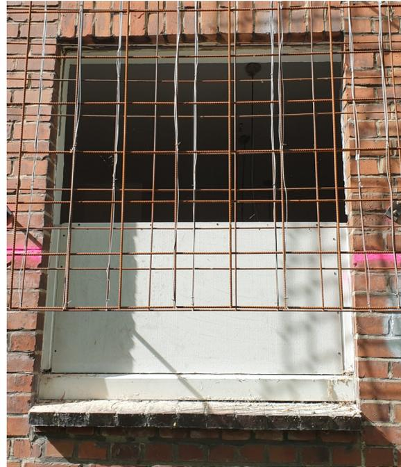
*Abbildung 2-4: Ansicht des für den zweiten Versuch verkleinerten Fensterquerschnitts von innen und außen*
