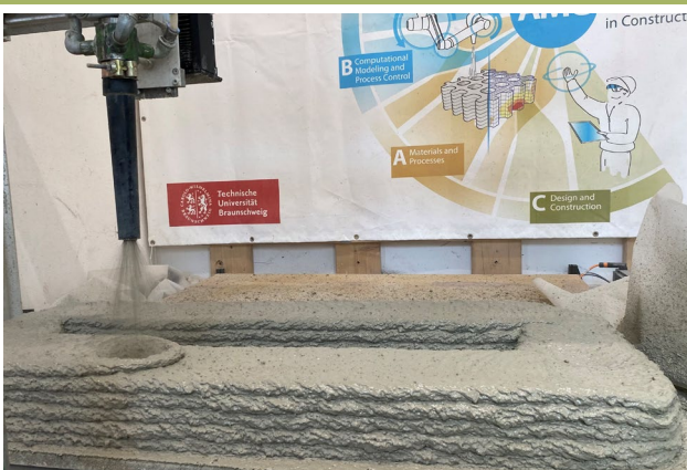
Additive Herstellung einer neu entwickelten Druckrezeptur mit einem Größtkorn von 8 mm im Shotcrete 3D Printing Verfahren
