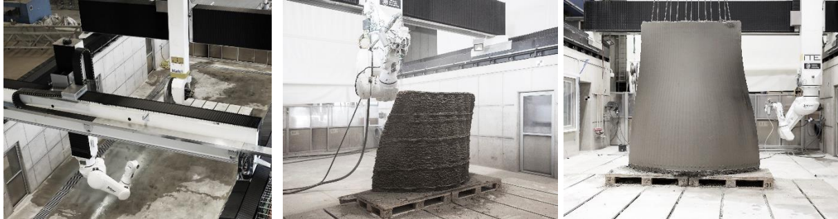
Abb. 1. Digitale Baufertigung an der Technische Universität Braunschweig
