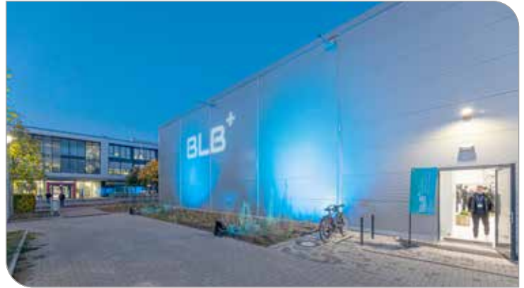
Außenansicht des CircularLab
