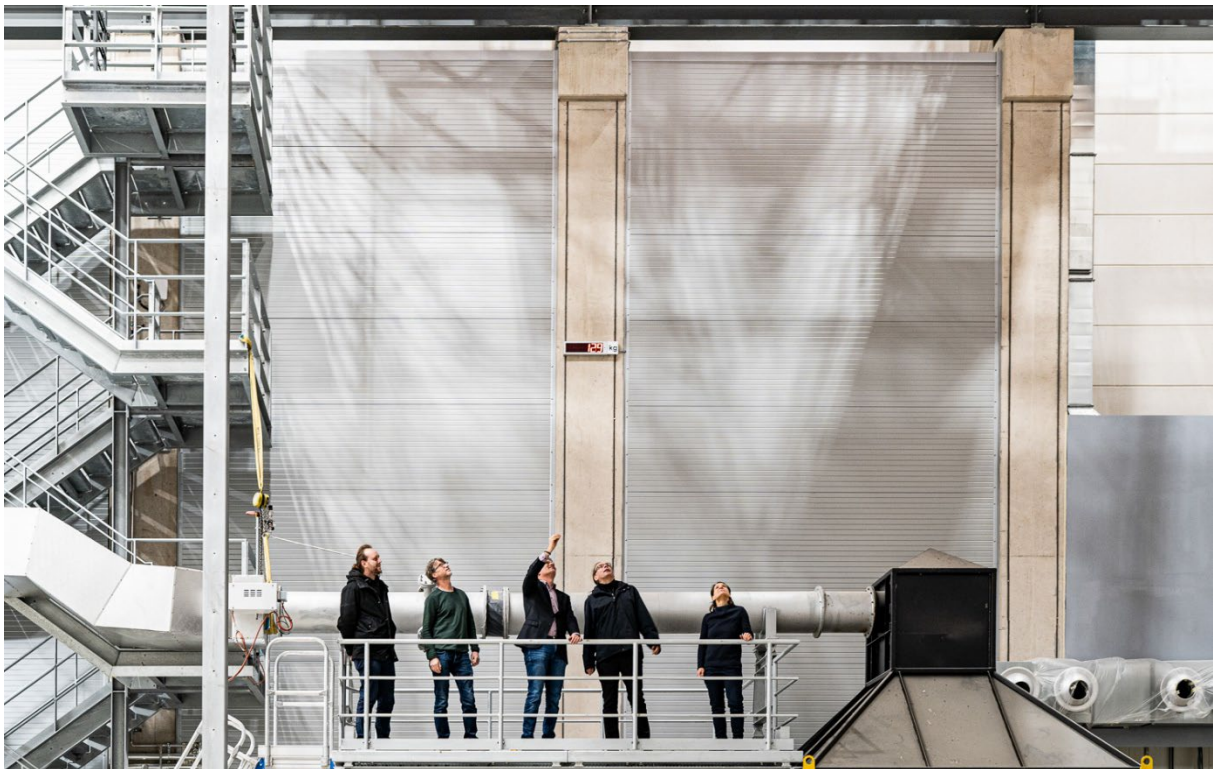
Abbildung: Baustelle ZeBra, Maddie Franke/TU Braunschweig, März 2023
