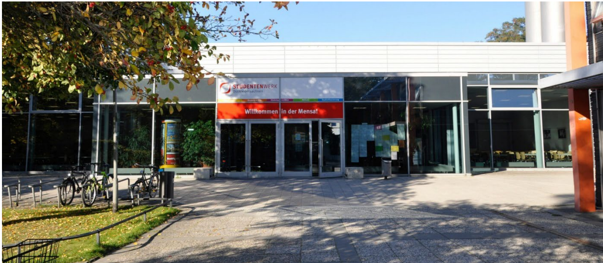
Zugang zur Mensa 1 und zum AStA (rechts) | STW-ON
