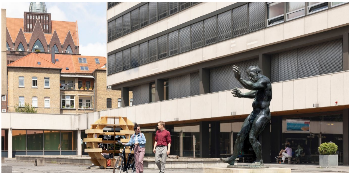
Forumsgebäude | Kruszewski, Marek/TU Braunschweig
