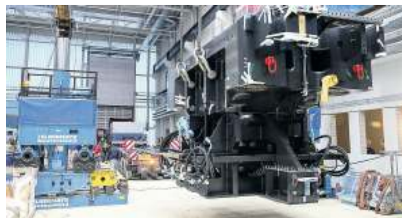
Der Unterholm der Hybridspritzgusspresse wird im Technikum des „OHLF“-Forschungsneubaus in Wolfsburg abgeladen.
